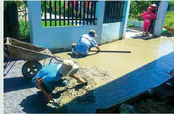
Nhân công tỉ mỉ trong từng công đoạn.
