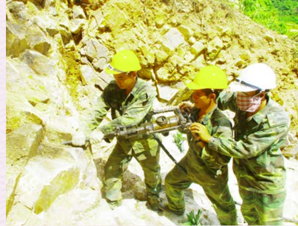
Cán bộ, chiến sĩ Tiểu đoàn Công binh 792 thi công công trình chiến đấu
