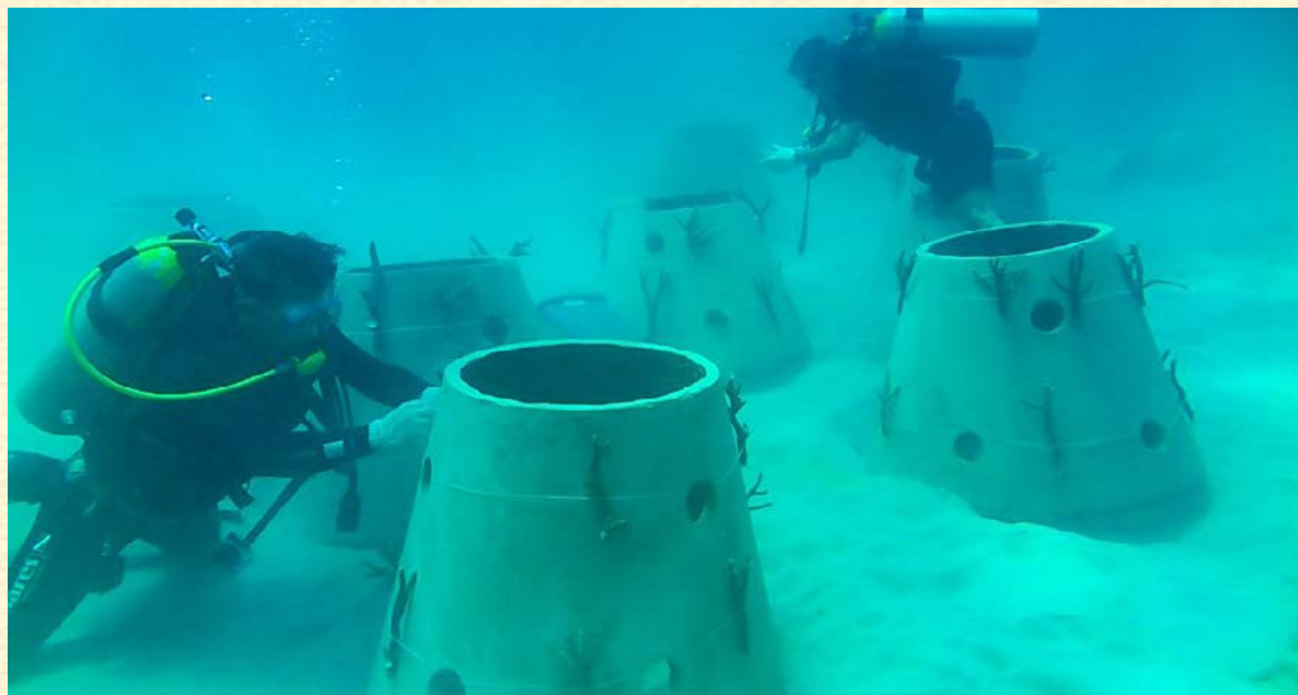
Ngư dân trồng san hô trên nền rạn nhân tạo bằng bốn bê tông
