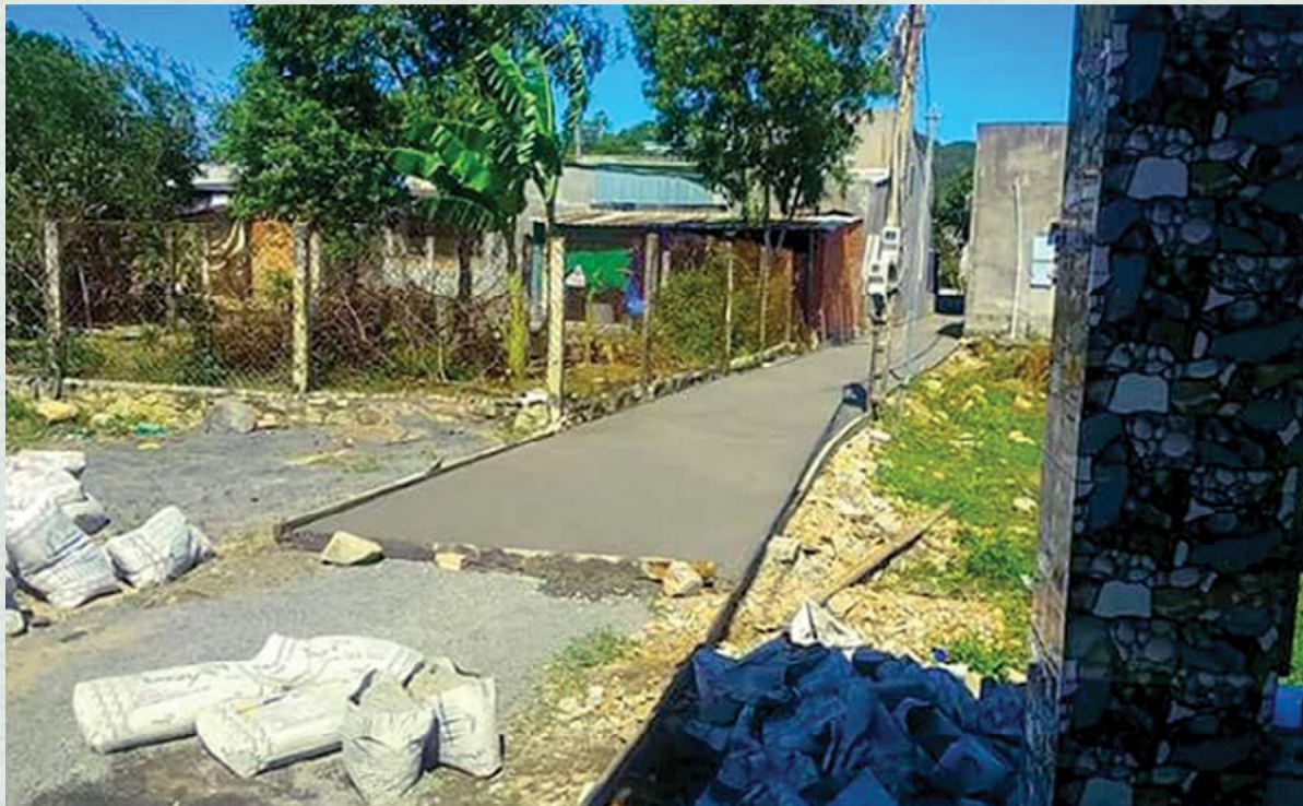
Đoạn đường được “phủ lớp áo” bê tông mới
