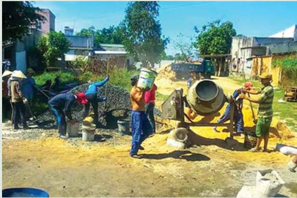
Công đoạn đổ đá, trộn vữa làm mới đoạn đường.
